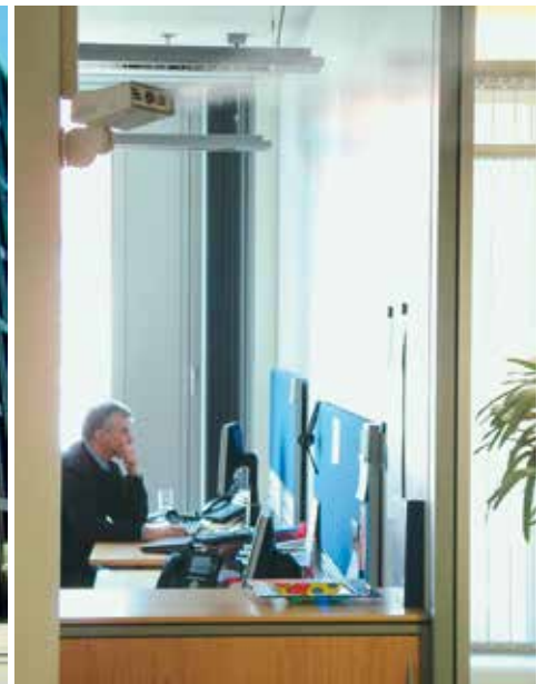
Die Direkt-Raumluftbefeuchter wurden nachgerüstet.
