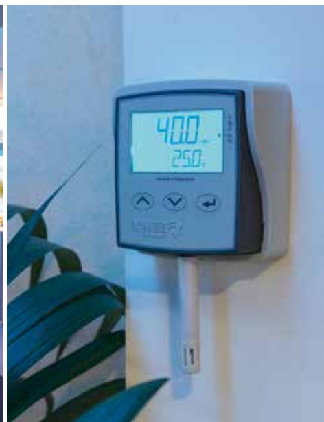
Ein digitaler Feuchte- und Temperaturfühler regelt die Hochdruckvernebelung.
